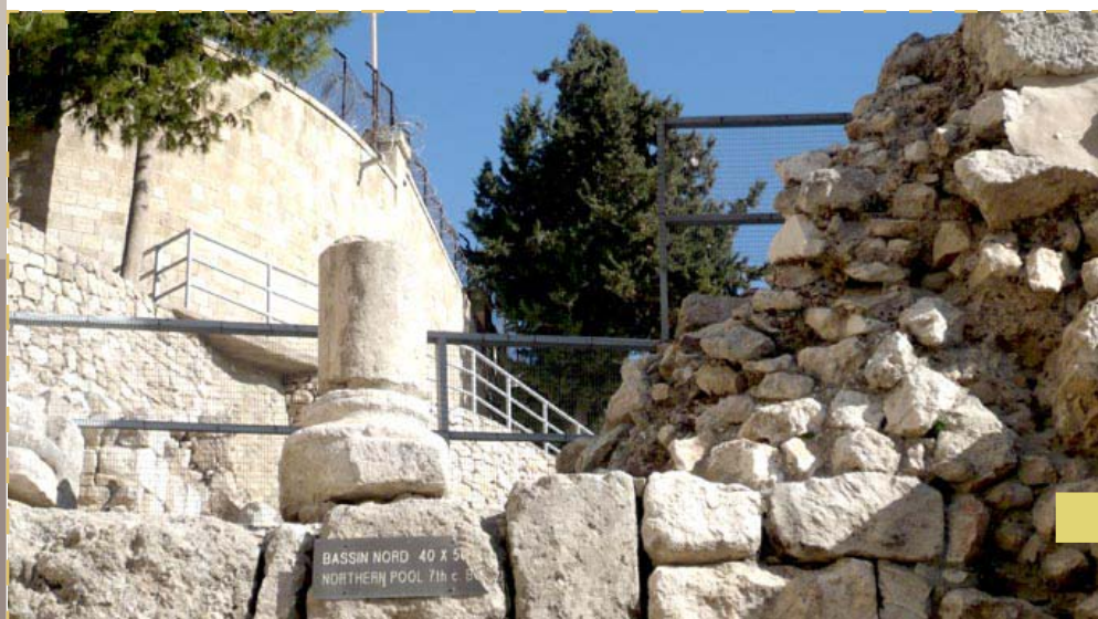
Parte superior de una de las piscinas y muro de contención protegido para proteger el lugar.
