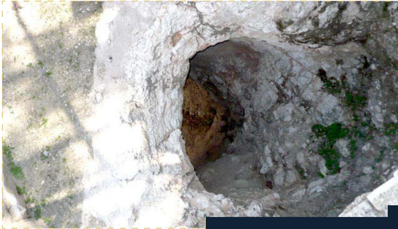
Vista superior de una de las cisternas subterráneas.
