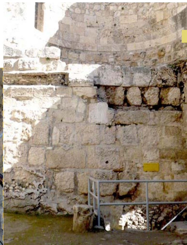
Escalera para acceder a las cisternas.
