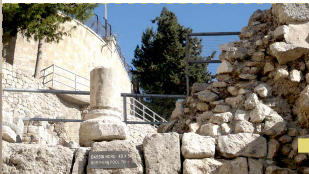
Parte superior de una de las piscinas y muro de contención protegido para proteger el lugar.
