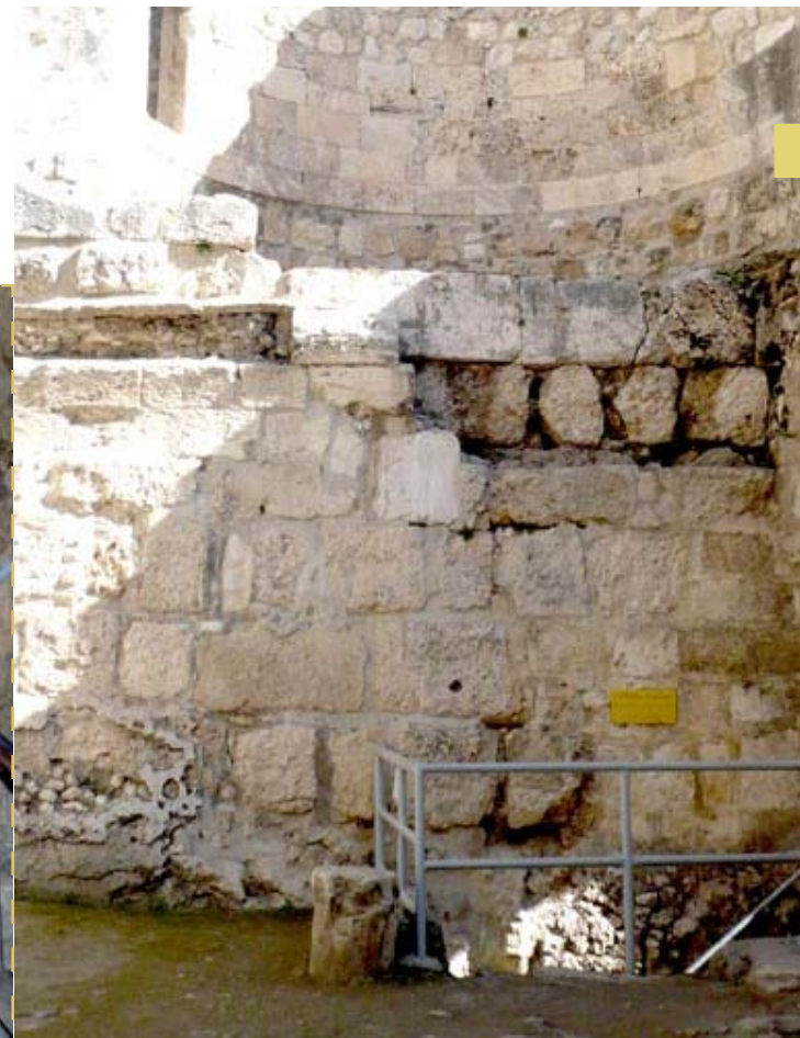
Escalera para acceder a las cisternas.
