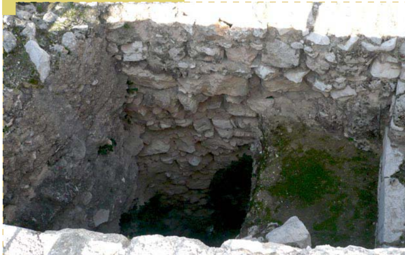
Antiguas escaleras de ingreso a las cisternas.
