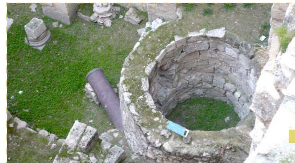
Restos de columnas y depósito de agua.
